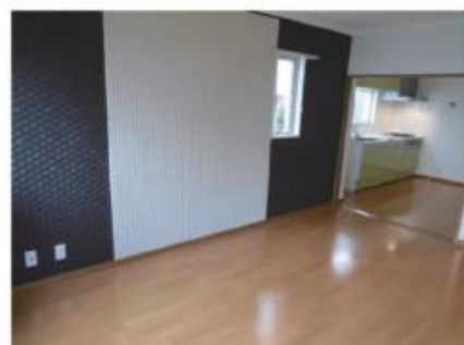
施工例 エコカラットを中心にシックなダーク色のクロスでお洒落な雰囲気仕上げました。
